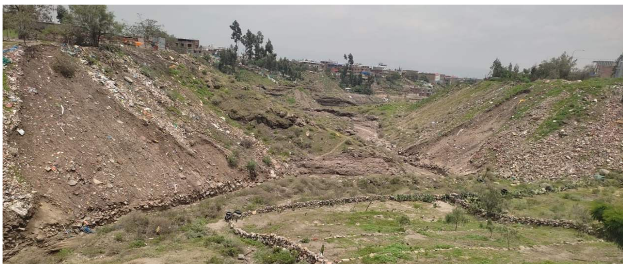
IMAGEN 02: SE MUESTRA LA COLMATACION LA QUEBRADA S/N SE REQUIERE DE MAYOR VEGETACION EN LOS TALUDES PARA ESTABILIZAR Y EVITAR LA EROSION
